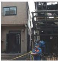
隣家火災 写真左:レスコハウス
