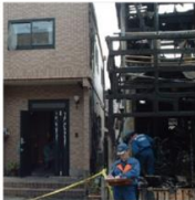
隣家火災 写真左:レスコハウス
