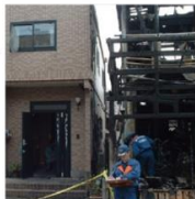
隣家火災 写真左:レスコハウス
