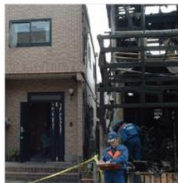
隣家火災 写真左:レスコハウス
