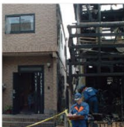
隣家火災 写真左:レスコハウス
